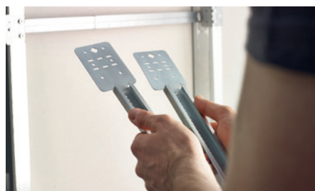
2. Uchwyty mają regulowaną szerokość, możesz je rozsunąć w zakresie 41-61 cm
