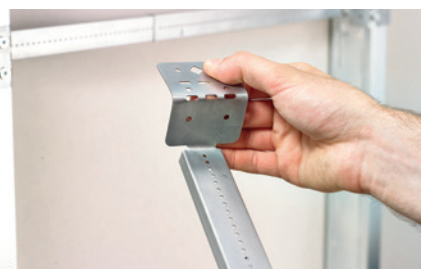
3. Łatwe do zgięcia końce pozwalają dopasować je do konstrukcji ściany.
