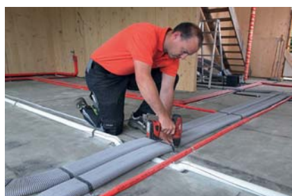
▲ Układanie rur Zehnder Onfloor na wylewce.
