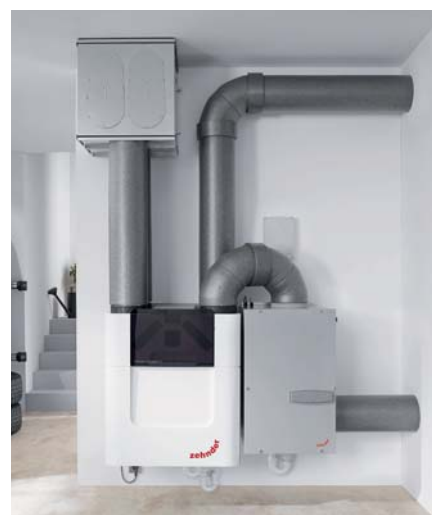
▲ Montaż systemowego wymiennika glikolowego dla podniesienia sprawności układu latem i zimą.
