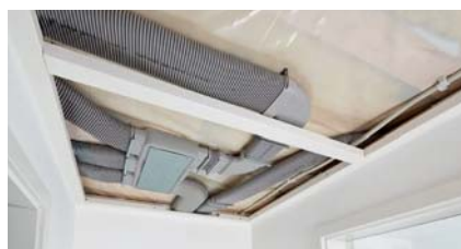
▲ Integrowanie rur Zehnder Onfloor w suficie podwieszanym.
