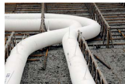
▲ Rury Zehnder ComfoFresh posadowione w wylewce betonowej.
